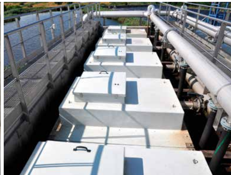
Fot. 3. Jeden z dwóch ciągów modułów membran
